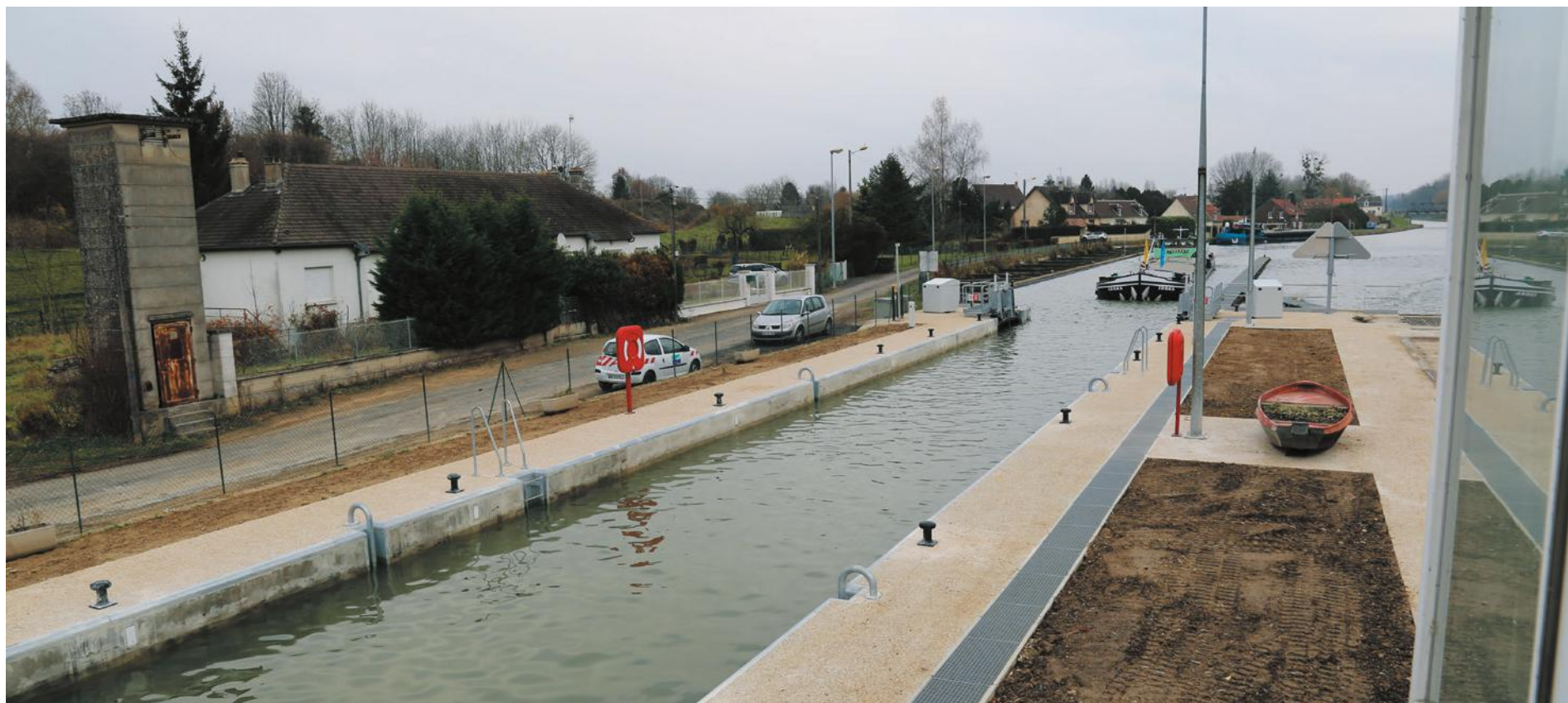
Écluse de Belleuvre après travaux
