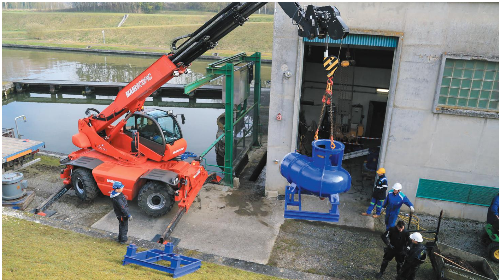
Canal du Nord Ecluse N°15 de Languevoisin, remplacement d'une pompe de relevage.
