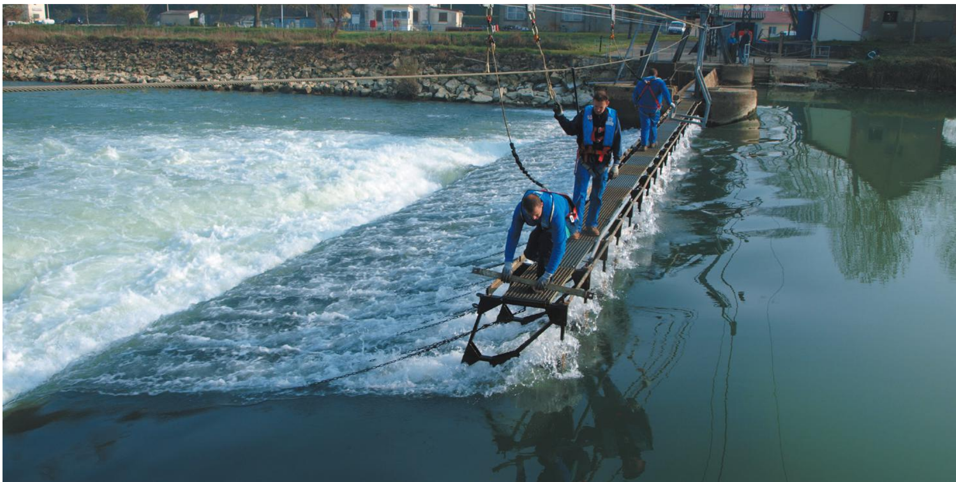
Manoeuvres au barrage de Couvrot
