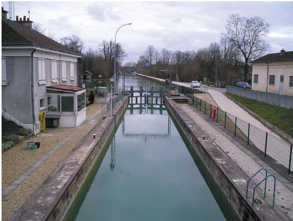
Écluse de Châlons-en-Champagne
