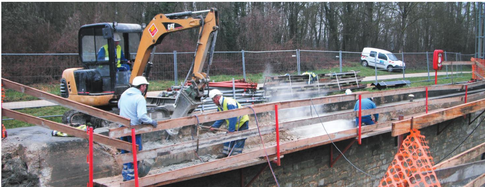
Réfection de l'écluse de Sarry
